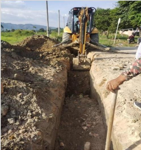
Construcción colector sanitario sector las américas, excavación mecánica
