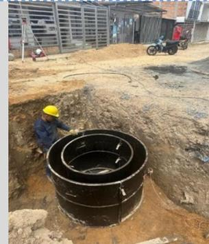
Fundición de pozo de inspeccion pz1 y su respectivo relleno en recebo
